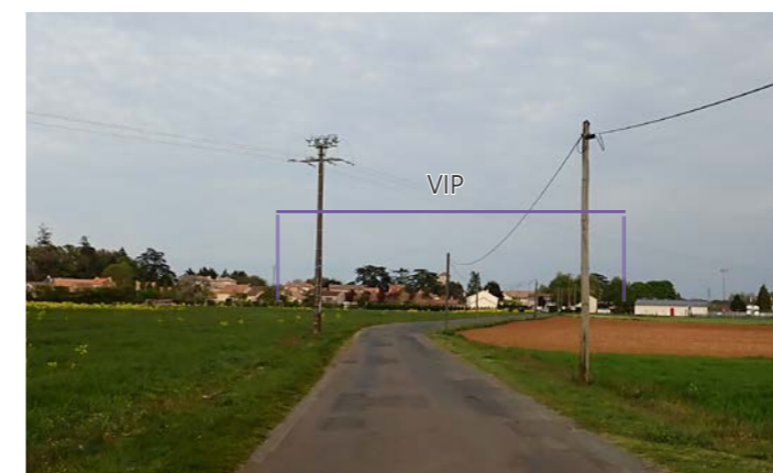
Photo 81 : Depuis la route communale à l'ouest de Blanzay, les vues sont ouvertes sur la silhouette de bourg et le VIP qui apparaît derrière
